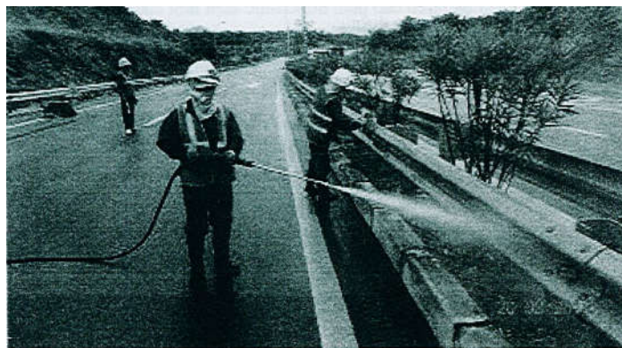
Hình 6-3 Làm sạch hộ lan bằng phụt nước cao áp
