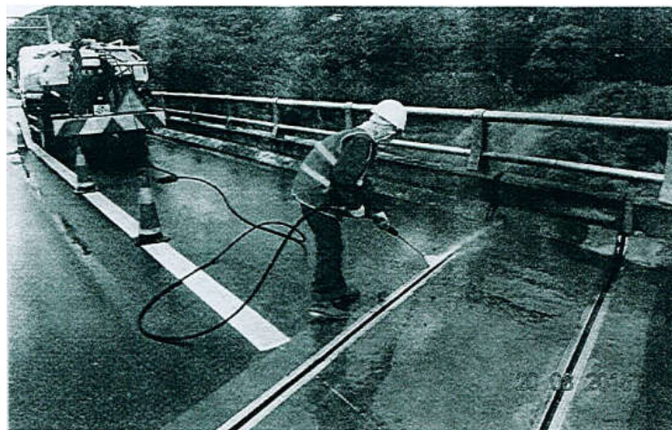
Hình 6-9 Vệ sinh khe co giãn bằng phụt nước cao áp
