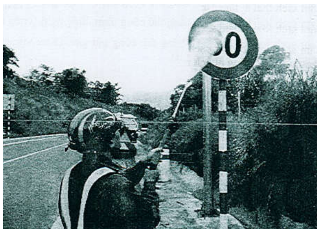
Hình 6-4 Làm sạch biển báo bằng phụt nước cao áp
